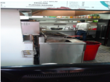
Fotografía 7. Freidora a gas natural.
